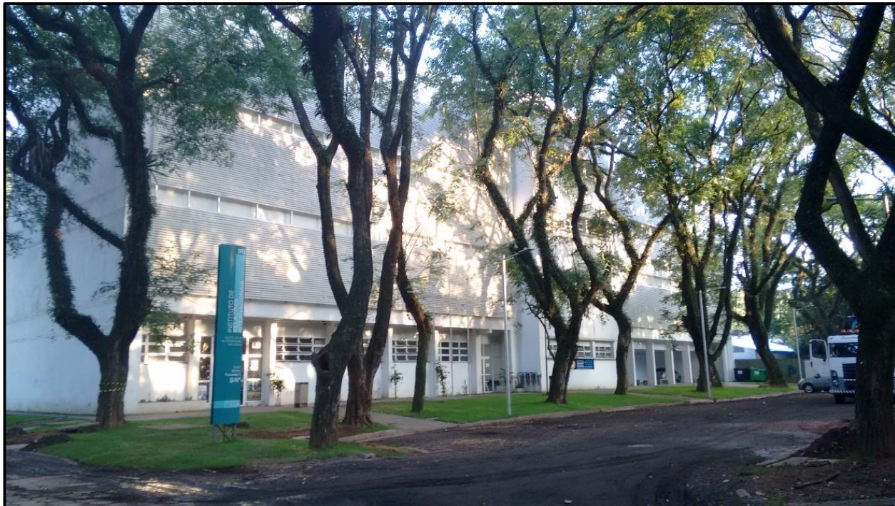
Prédio do IRI
